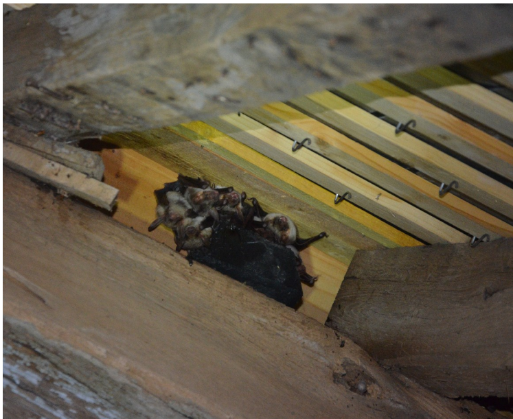
Figure 4: Colonie de Grands murins dans les combles de l'église Sainte-Suzanne
